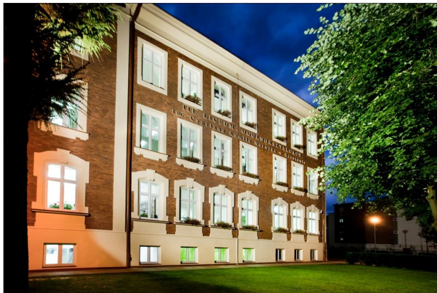
Budynek III Liceum Ogólnokształcącego im. Cypriana Kamila Norwida w Rzeszowie przy ulicy Szopena 11.
